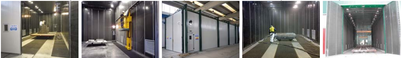
Collocazione interno fabbricato con raschiatori e coclea
