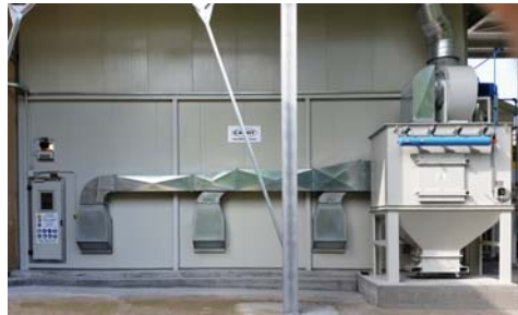
Filtro ad alta efficienza con precamera di rallentamento flusso polveri su impatto filtri
